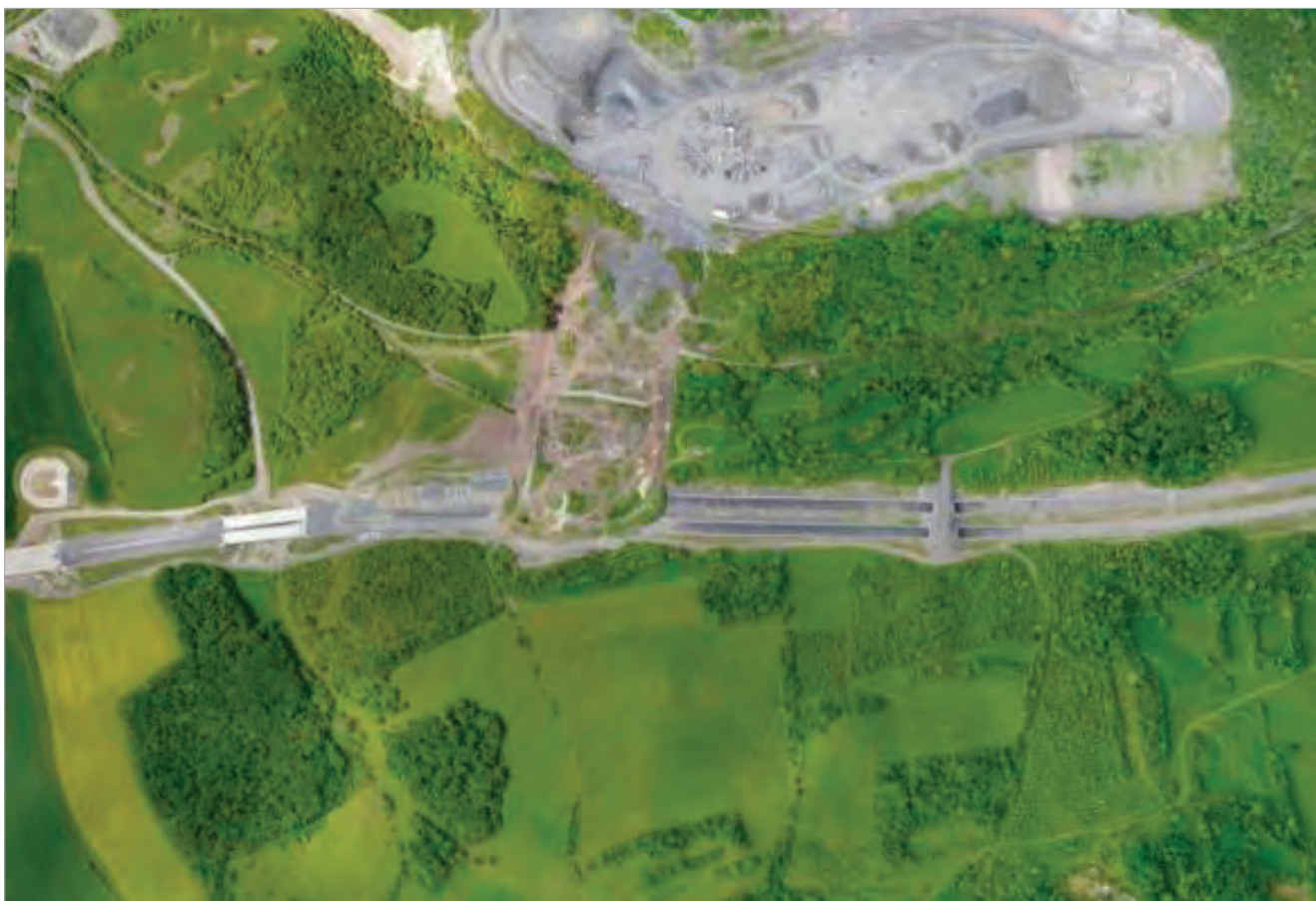
Obr. 9: Rozsáhlý skluz v oblasti dálnice D8 (rok 2013). [4]
